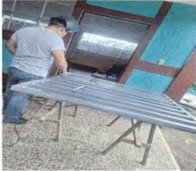
Fotografía 11 INSTALACIÓN DE ESTRUCTURA PORTANTE DE METAL
