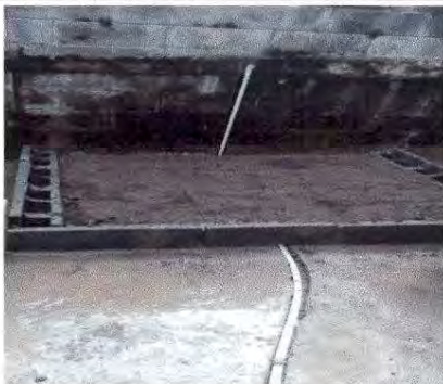
Fotografía 13 SUSTITUCIÓN DE PILA DE CEMENTO DE DOS LAVADEROS
