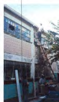
Fotografía 4 REPARACION DE BAJADA DE AGUA PLUVIAL TUVO PVC 3
