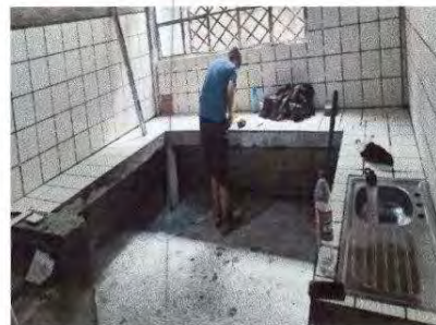
Fotografía 8 COLOCACION DE AZULEJO
