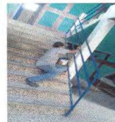
Fotografía 8 MANTENIMIENTO DE BARANDA DE METAL
