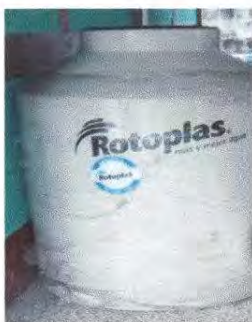
Fotografía 9 SUSTITUCION DE DEPOSITO DE AGUA 1100 LT
