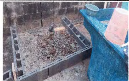
Fotografía 16 SUSTITUCION DE PILA DE CEMENTO DE DOS LAVADEROS
