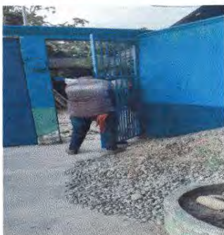
Fotografía 7 MANTENIMIENTO DE PORTON
