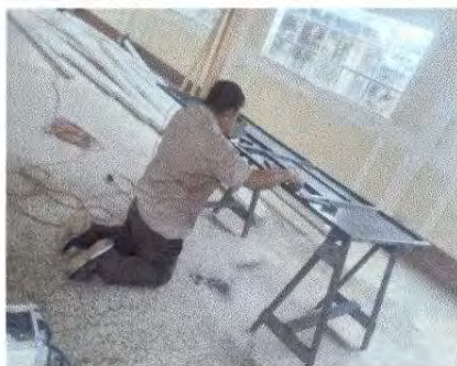
Fotografía 1 MANTENIMIENTO A ESTRUCTURA (LIJADO, CAMBIO DE TUBO, CEPILLADO, SUJECCIONES, APLICACIÓN DE PINTURA)
