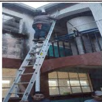
Fotografía 3 SUSTITUCION DE CANAL DE PVC
