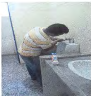
Fotografía 7 SUSTITUCION DE LLAVE DE MINGITORIO
