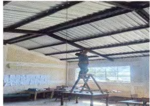
Fotografía 12 INSTALACIÓN DE UNIDADES DE LUZ (INCLUYE INTERRUPTOR, DUCTO Y CABLE ELÉCTRICO)
